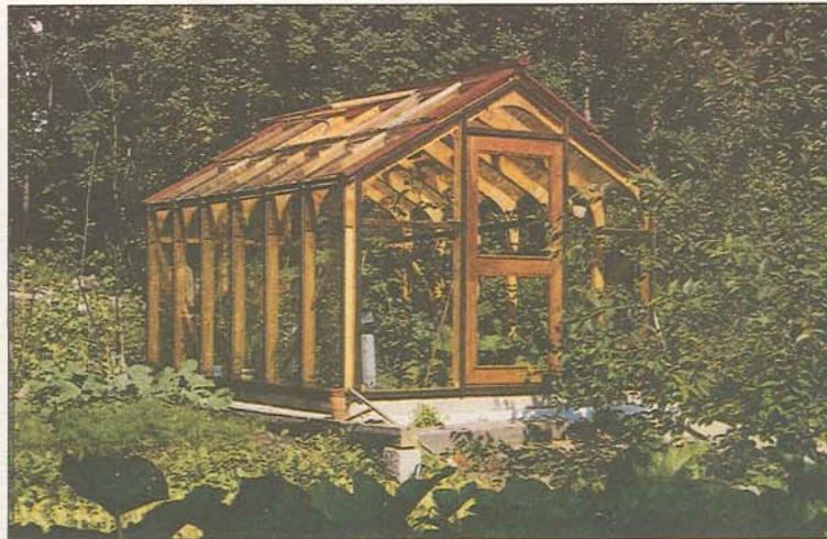
Arkitekten Anders Nykvist har tagit Solosågen i miljöns tjänst. Det här solcellsdrivna växthuset är byggt av kärnfura. Tack vare kärnvirken undviker man miljöskadlig tryckimpregnering.
