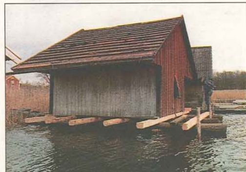
Den gamla fiskeboden har lyft upp på domkrafter och håller på att få ett nytt "underrede" av stockar från skogen på ön.
