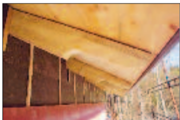
Museibygnaden innehåller många intressanta detaljlösningar, både ute och inne.
