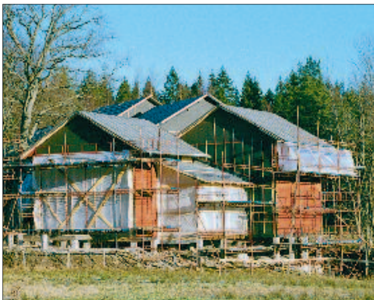
Kungajakt och Viltmuseet byggs med ekologiska metoder av byggmaterial hämtat från närområdet. Det mesta virket har sågats med Solosåg
