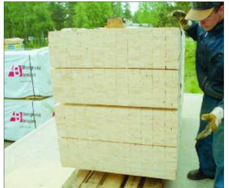
Det blir varken skägg eller sprickor i ändarna när hela virkespaketet kapas på en gång.
