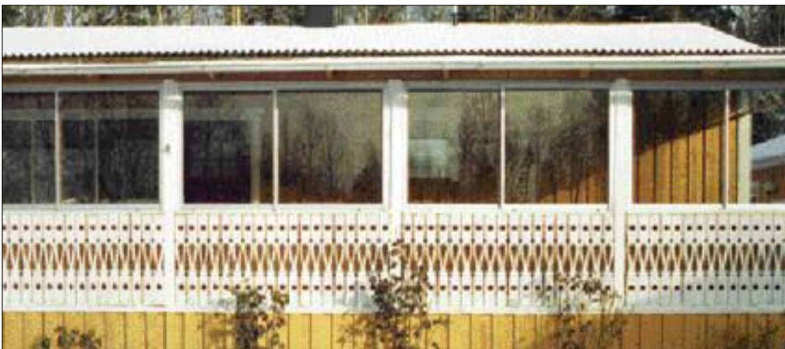
Sven Gustavsson har tillverkat nästan allt till sina hus med solosågat virke, inklusive fönsterkarmar, dörrar och de konstfullt utsirade staketspjalorna.
