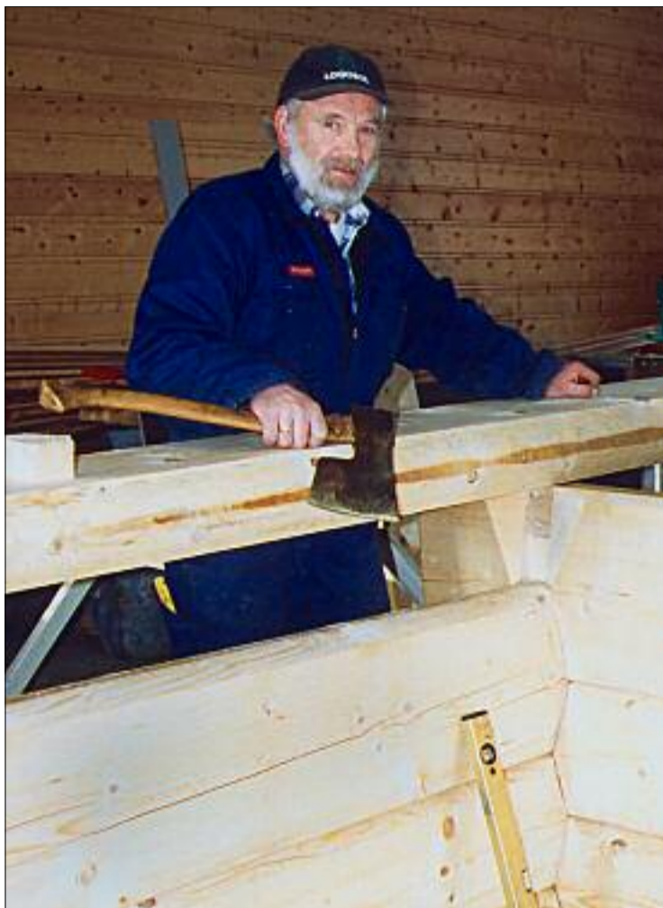
Arne er godt i gang med stabburet, herfra og opp skal veggene legges ut 90cm på to sider slik at det blir soveplass.
