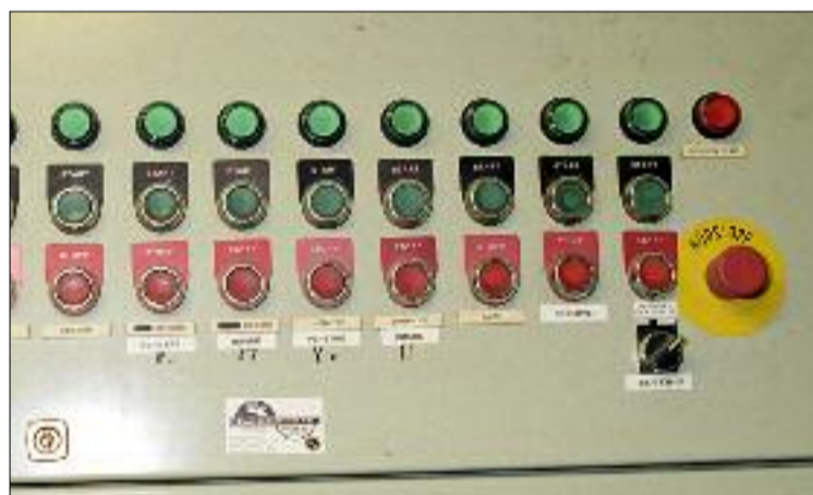
Bara elinstallationen för industrihyveln kostade 100 000 norska kronor.
