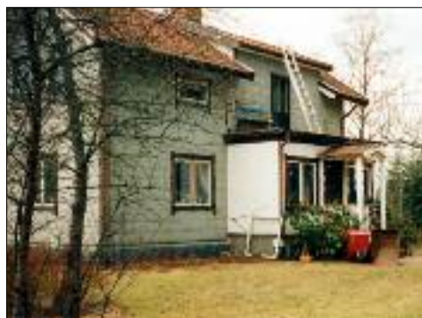
Huset före renovering.
