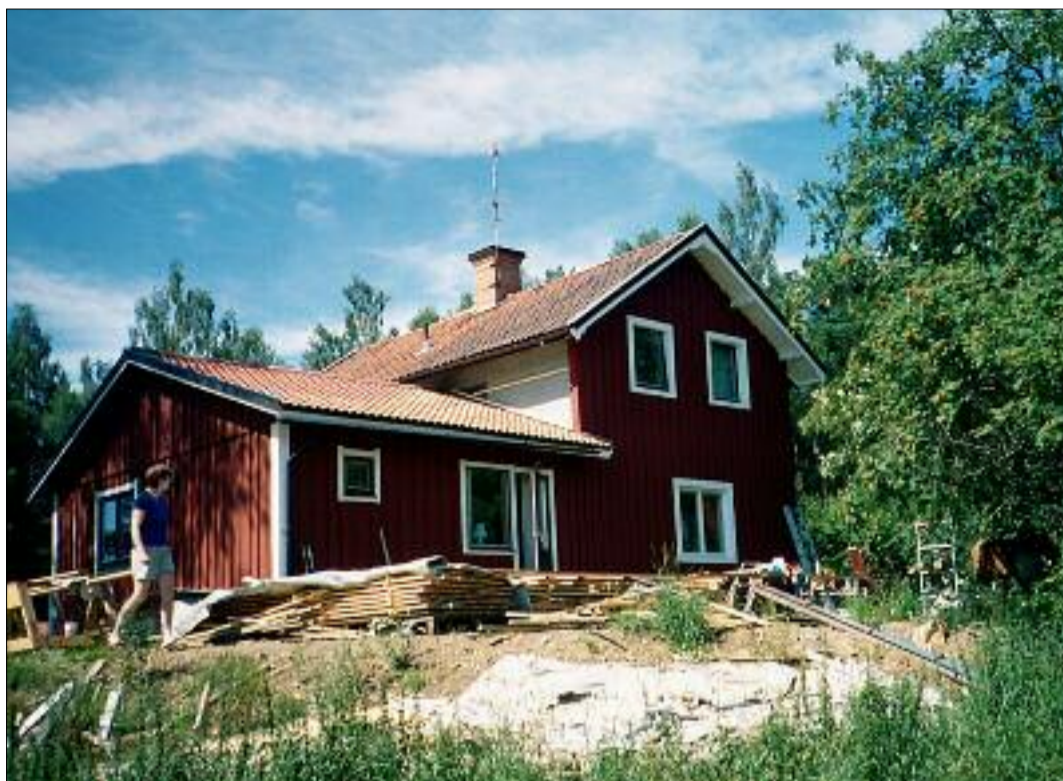
Så här fin blev villan efter att eternitplattorna tagits bort och den solosågade fasaden spikats upp och målats röd.
