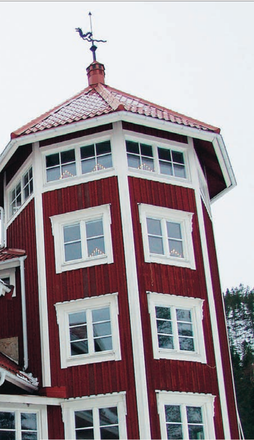
Allt virke som syns på bilden, inklusive trappan, är solosågat. Trappan leder upp till idérummet överst i tornet.
