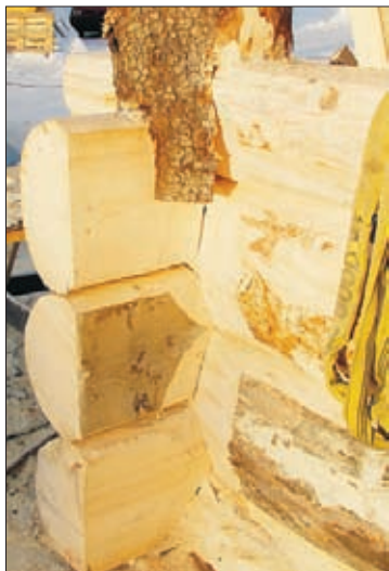
Stockarna klyvs så att innerväggarna blir släta.
