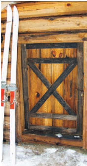
Ett uthus byggt av impregnerade stockar.
