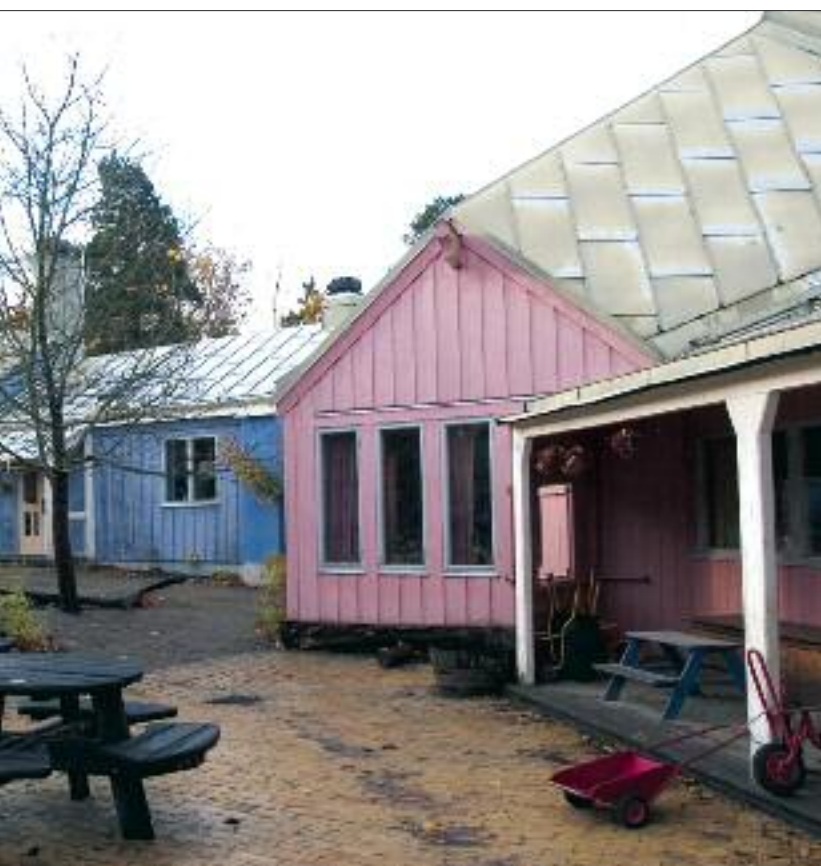
Bromma är byggda av virke som solosågats av lärare, elever och föräld- h farföräldrar vars kunskaper är ovärderliga.
