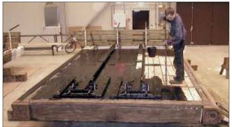
Slussportarna repareras inomhus under vintern. Skadat trä byts ut och sedan skyddas de på gammalt sätt med tjära. Solosågen är det enda moderna som används.
