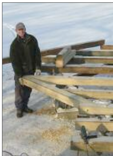
Bygge av solosågad brygga.
