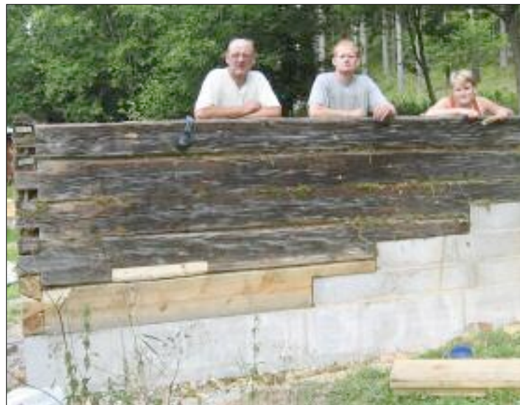
Ulf, Fredrik och Emma vid den första resta väggen. Stocken i botten är solosågad och timmerfräst.
