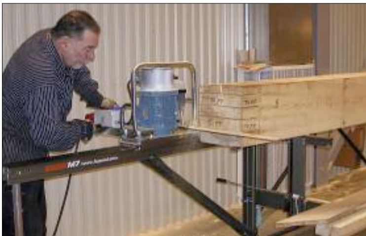
Först sågar Lasse Holgersson ut blocket, sedan två tappar på varje sida som håller ihop slussporten.
