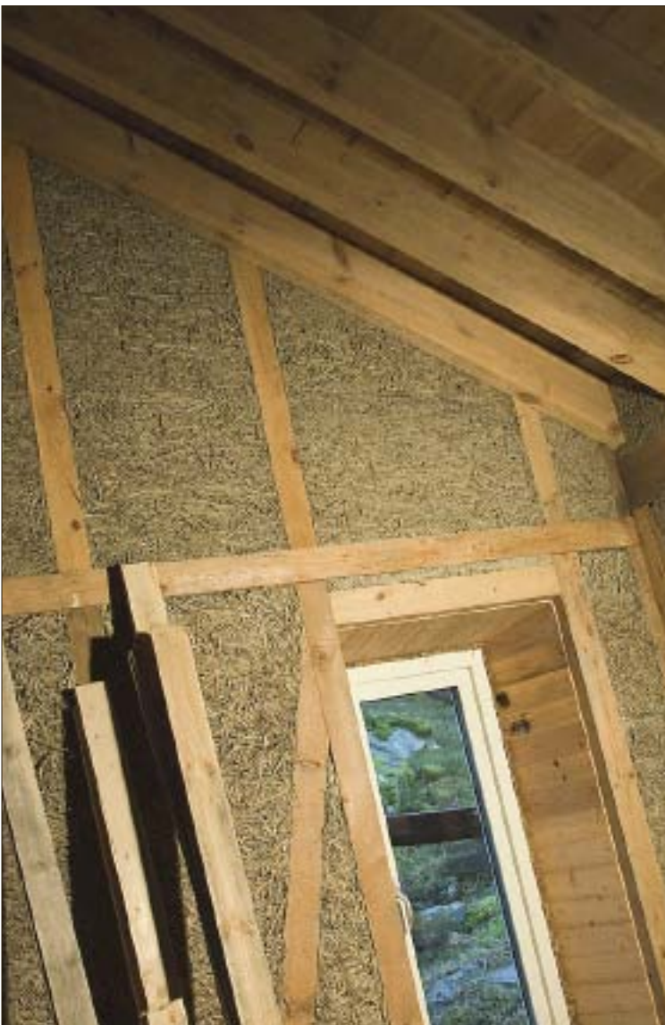
Mellan träreglarna består väggarna av sammanpressad halm och lera. Det ger en tung byggnadsstomme med bra isolering.
