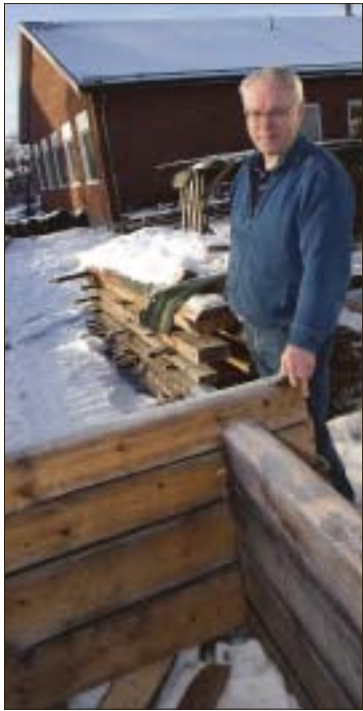
Ett av elevernas projekt på Hagaskolan är att timra en liten stuga. Att man använder en hakknut beror inte bara på att den är enkel, det är den vanligaste knuten i Västerbotten.
