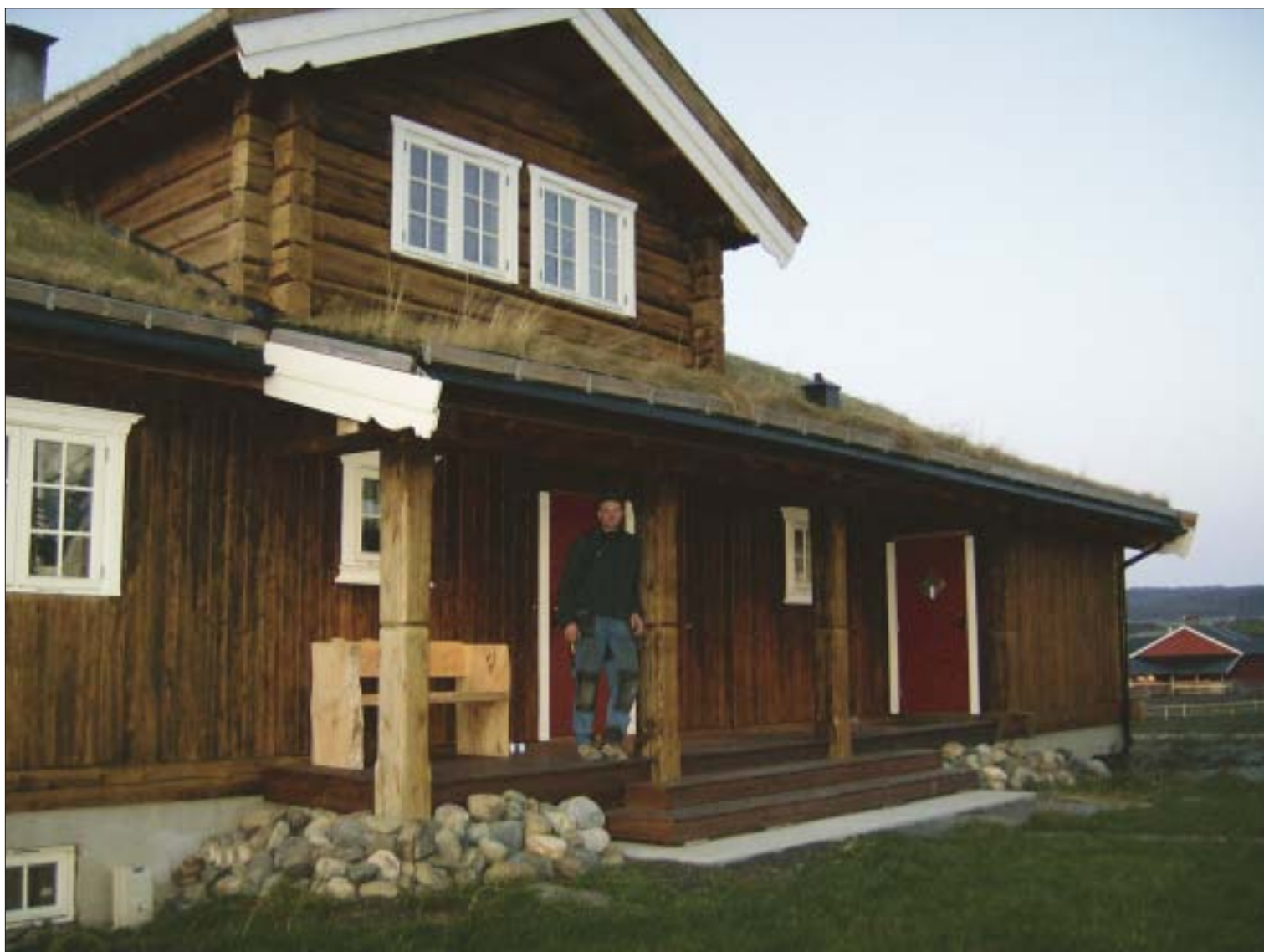
Jon Ole Bakheim har sammen med sin samboer Aimee Roesen bygget et prakthus i stavlaft og 8" laft på hjemmeplassen i Hegra, Nord-Trøndelag.
