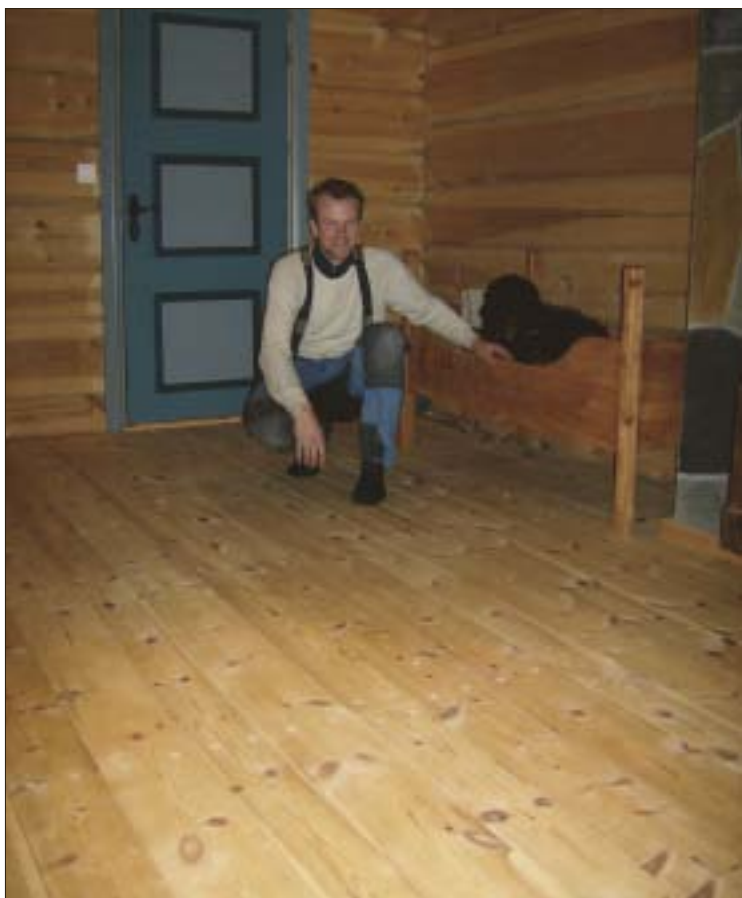
Både dobbelfalskledningen, panelene innvendig, gulvbordene, underpanel og listverket produsert på egen høvel.
