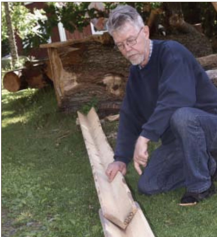
– Nockarna och hängrännorna tillverkas i sektionen, förklarar Carl Gustaf Olofsson och visar att längderna kan justeras utan såg. Nedan syns nockarna på plats.
