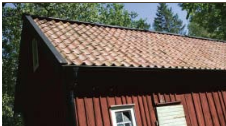
– Nockarna och hängrännorna tillverkas i sektionen, förklarar Carl Gustaf Olofsson och visar att längderna kan justeras utan såg. Nedan syns nockarna på plats.
