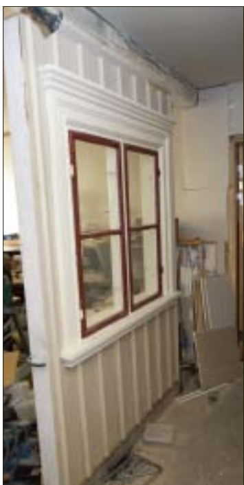
En vägg för mässor med exempel på olika lister och paneler i gammal stil.
