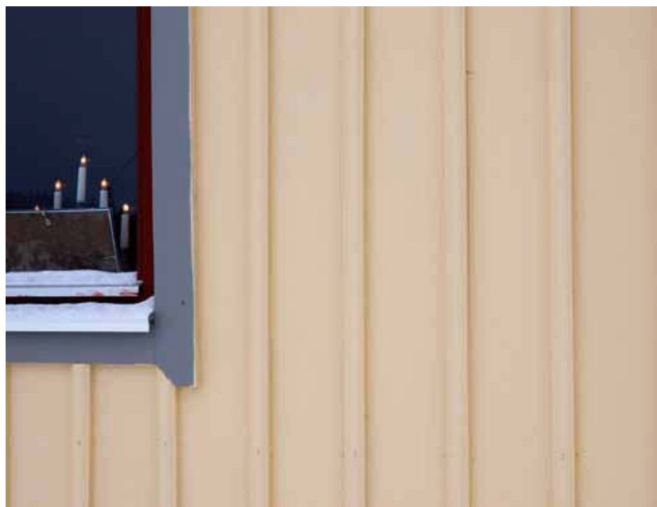
Hela fasaden till det gamla huset och utbyggnaden har hyvlats och dimensionerats med Solohyveln. Samma hyvel har använts för att tillverka den hattformade locklärken.
