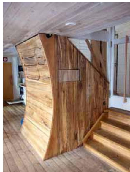
Akkumulatortanken är inbyggt i köket, under trappan till övervåningen
