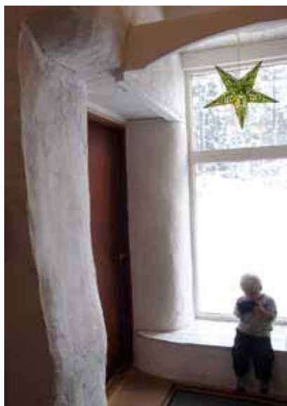
Pelarna i entrén är vitmålad och lertäckt halm.
