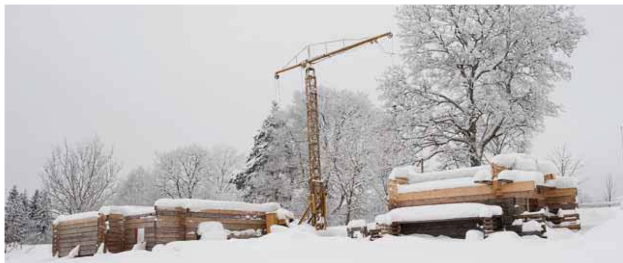
Rolf Ericsson fortsätter att timra. Byggplatsen i vinterskrud.
