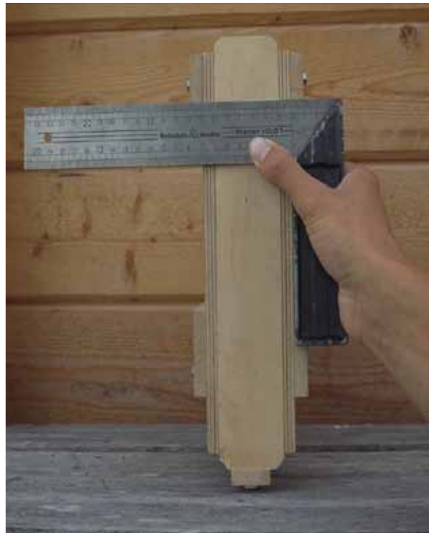
Kontrollera att listerna sitter mitt emot varandra.
